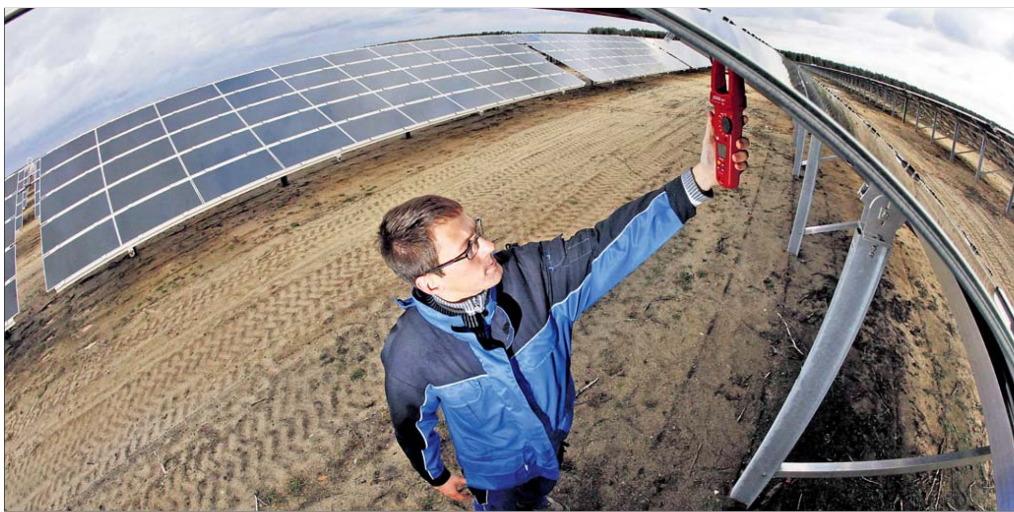
Von der Solarbranche – hier das weltweit zweitgrößte Photovoltaik-Kraftwerk Lieberose nördlich von Cottbus (Brandenburg) – werden im nächsten Jahr kräftige Impulse erwartet
