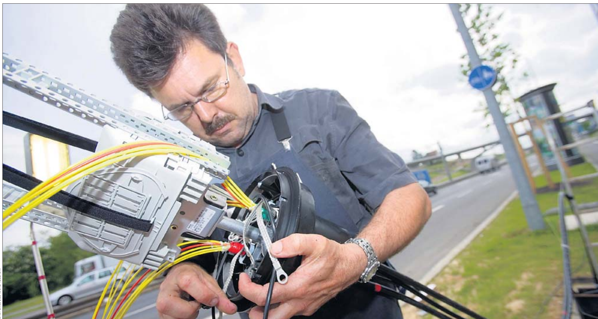
DSL ist nicht überall verfügbar: Vor allem auf dem Land werden Breitbandkabel nur mancherorts verlegt
