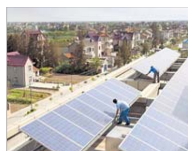
Wartungsarbeiten an einer Solaranlage in Chongming bei Shanghai
